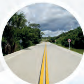
Vías Concreto Usadas para el tránsito urbano
