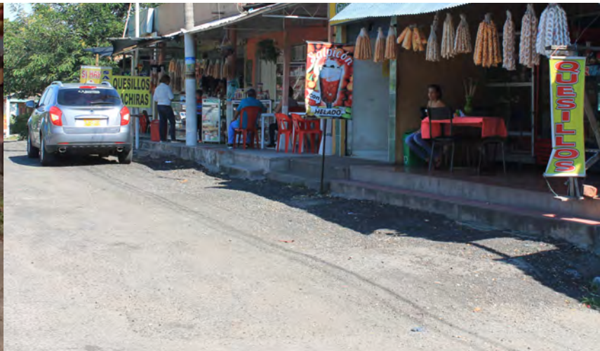
▲ Después. Zona de parqueadero del sector Las Brisas.
