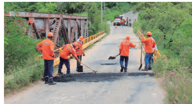
▲ Aplicación mezcla asfáltica.
