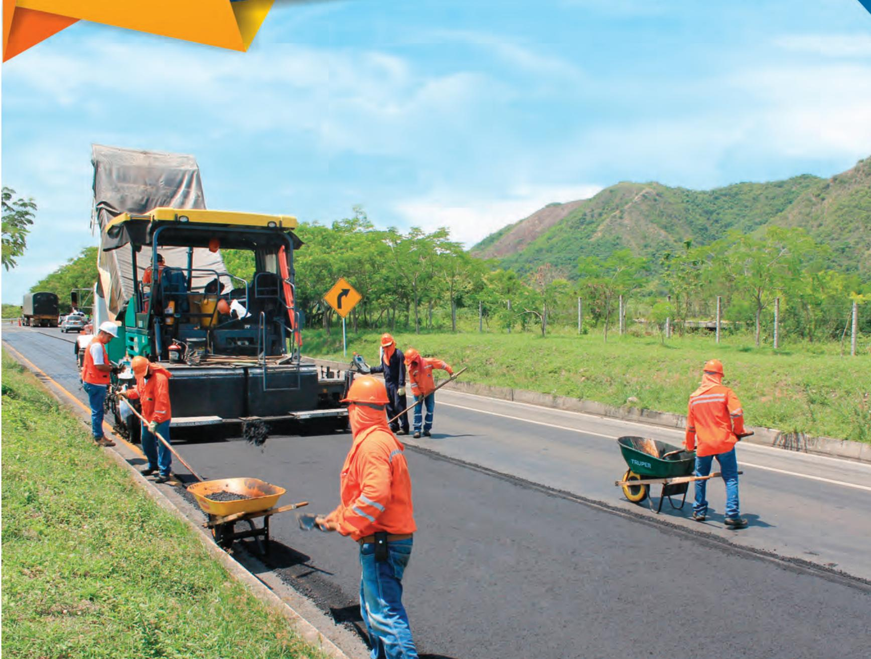
Instalación de mezcla asfáltica. Tramo 1: Variante Chicoral.
