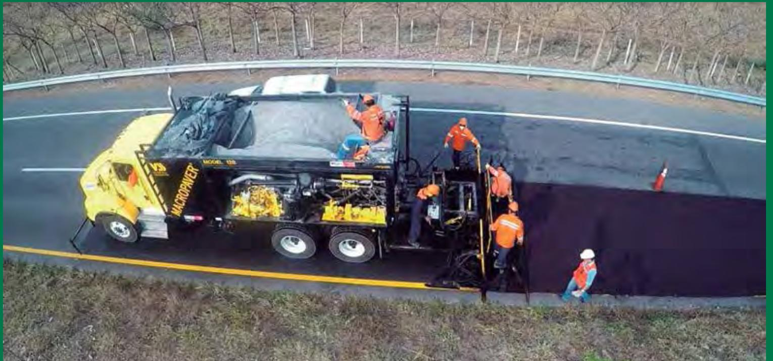
Concesionaria San Rafael adquirió la máquina Macropaver Slurry Seal Microsurfacing fabricada en California, Estados Unidos, donde producen sólo cuatro aparatos al año.
