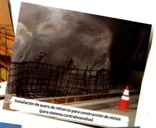
Instalación formaleta para cárcamo carril derecho acero de refuerzo muro instalado.
