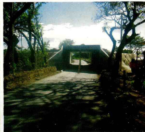
Este box culver fue realizado en la vereda de Potrerillo, con el fin de no interferir con la vía utilizada por la comunidad de este sector.
