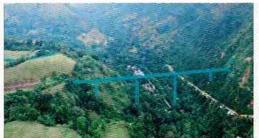
El método constructivo que se empleará en el Viaducto se denomina Método de Dovelas Sucesivas Fundidas In Situ con Voladizos Compensados; lo que permite construir los vanos del viaducto con disminución en tiempo y costos, con la mínima afectación de la naturaleza en la zona de influencia.
